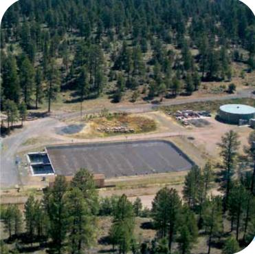
aérobie. Un âge des boues prolongé réduit considérablement la DBO des effluents et les concentrations d'ammoniac, plus particulièrement en climat froid. Le processus Biolac® prolongeant l'âge des boues produit des concentrations de DBO inférieures à 10 mg/l et une nitrification complète (moins de 1 mg/l d'ammoniac). Au moyen de modifications mineures, il est possible d'adapter le système de façon à accroître ses capacités de dénitrification et de déphosphatation biologique.
